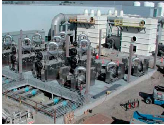
Рис. 2. Схема обработки повторно используемой сточной воды на станции Orange Country Water District Facility
