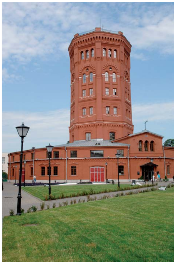
Рис. 4. Главная водопроводная станция
